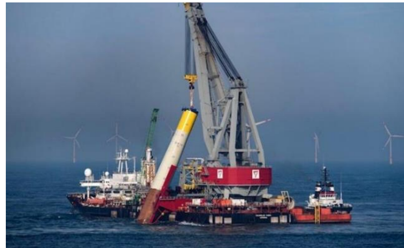
Installation par barge (reste en flottaison)
