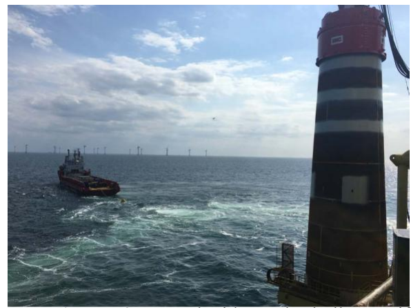
Figure 3. Grand rideau de bulles actif pendant la construction de Rentel.
